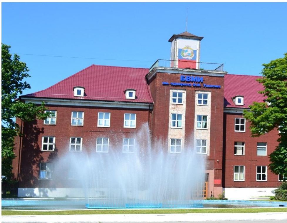
Фасад здания филиала ВУНЦ ВМФ «Военно-морская академия» в г. Калининграде
